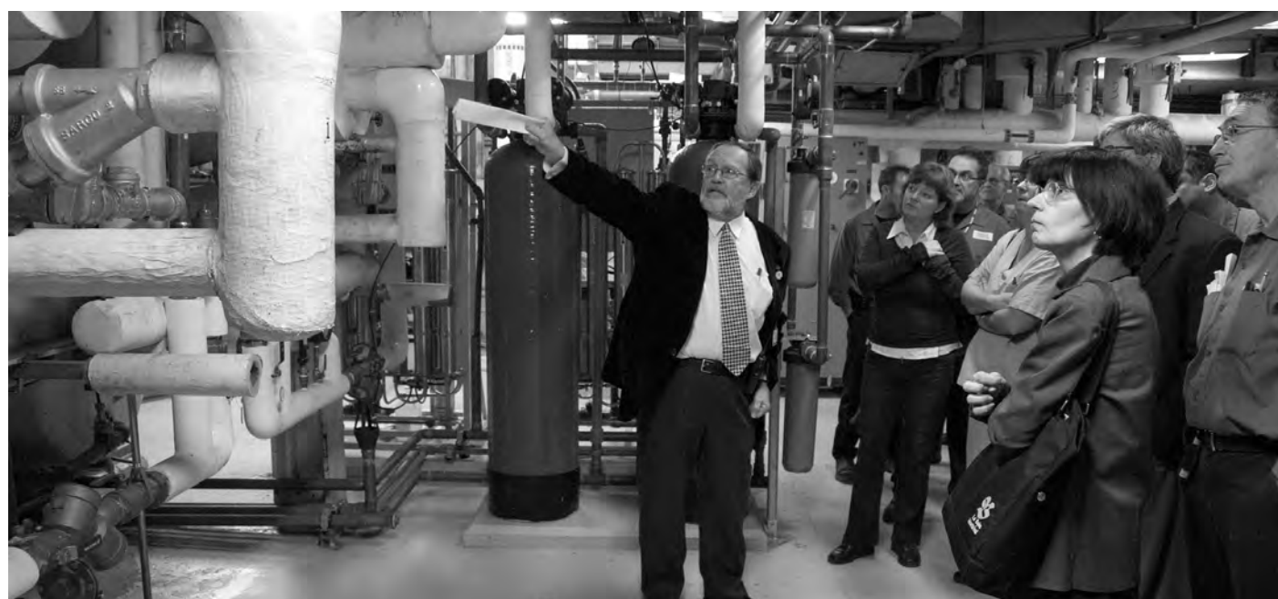
Le chef de secteur Gilles Peterson reçoit les visiteurs de la centrale thermique de l'Hôpital Notre-Dame.
